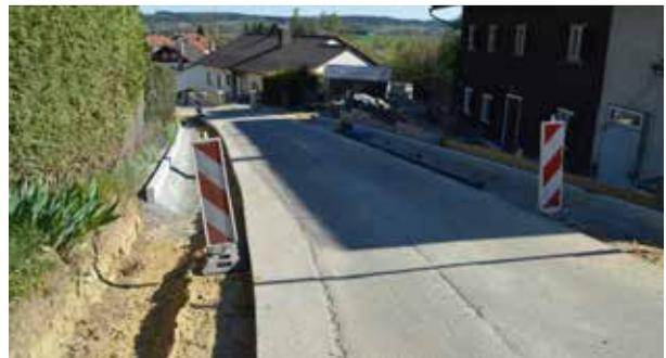
Aufgrund eines großen Wasserrohrbruches sowie diversen weiteren Arbeiten entstanden schwerwiegende Straßenschäden an der Reichenberger Straße, so dass diese dringend saniert werden musste.
